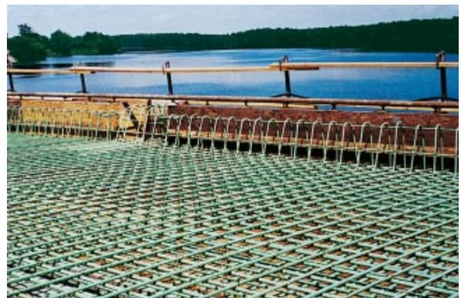
**Fig. 1-30. Armadura revestida con epoxis usada en el tablero de un puente. (IMG12498)**
