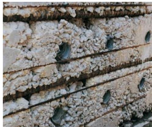
Fig. 1-8. Una buena consolidación (superior) es necesaria para lograrse un concreto denso y durable. Una consolidación pobre (inferior) puede resultar en corrosión temprana de la armadura (refuerzo) y baja resistencia a compresión. (IMG12491, IMG12490)
