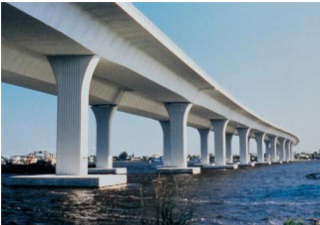
**Fig. 1-34. Los concretos de puentes expuestos al agua del mar se deben diseñar y proporcionar especialmente para la durabilidad. (IMG12495)**
