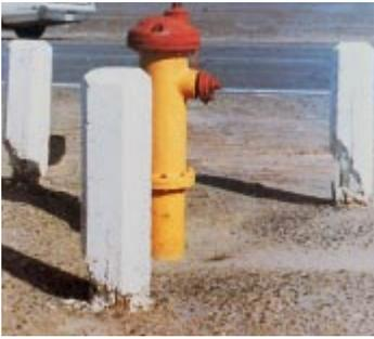
Fig. 1-31. El ataque de sulfatos es frecuentemente más severo en la región sometida a mojado y secado, la cual es, normalmente, cerca del nivel del suelo. Aquí los postes han sido atacados por sulfatos cerca del nivel del suelo. Véase también la foto menor a la derecha de la Fig. 1.32. El concreto está en mejor condición a mayores profundidades donde hay humedad. (IMG12497)
