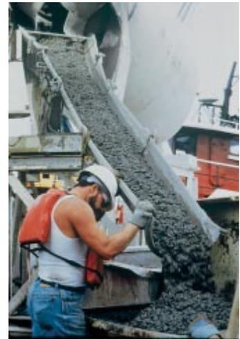
**Fig. 1-5. El concreto de buena trabajabilidad debería fluir lentamente hacia el lugar, sin segregación. (IMG12299)**
