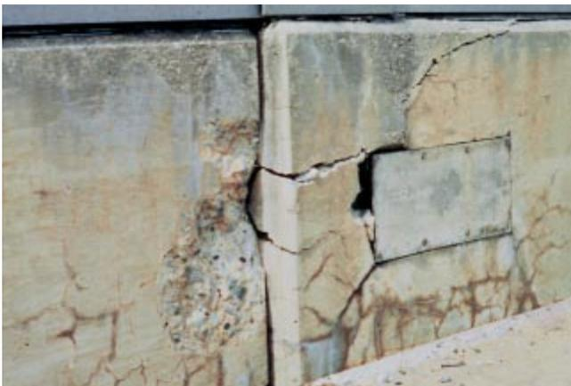
**Fig. 1-27. La fisuración, el cerramiento de las juntas y la dislocación lateral fueron causados por la severa reactividad álcali-agregado en este muro de parapeto. (IMG12295)**
